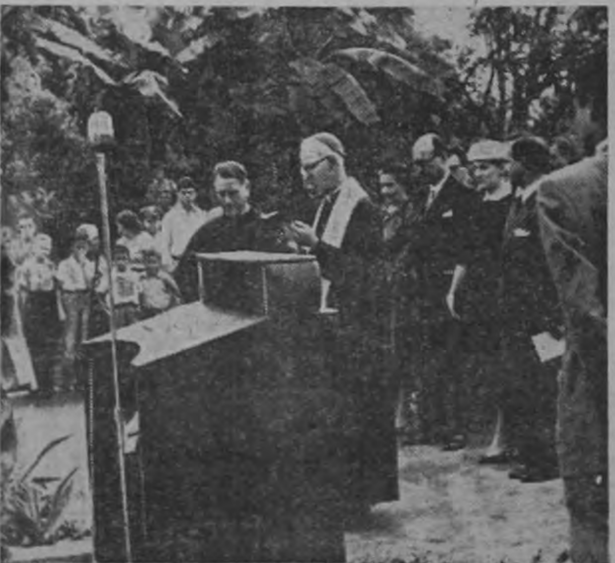
El Sr. Arzobispo de San José, Mons. Rubén Odio Herrera, auxiliado por un secretario, impartió la bendición al primer trecho de la carretera Presidente Wilson, que llegará hasta el aeropuerto Internacional El Coco.
